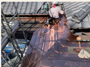
屋根工事の様子
