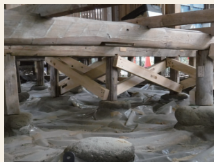
既存基礎補強の様子
